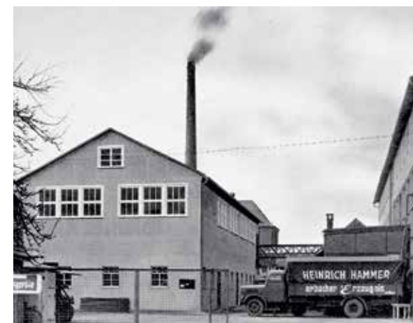
Dritte Station, Standort mit Tradition: die ehemaligen Produktionshallen der Heinrich Hammer-Faltbootwerft.
